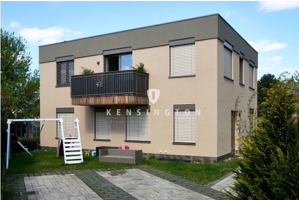
Außenansicht Haus Q
