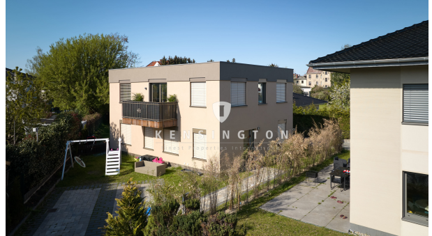
Außenansicht Haus Q
